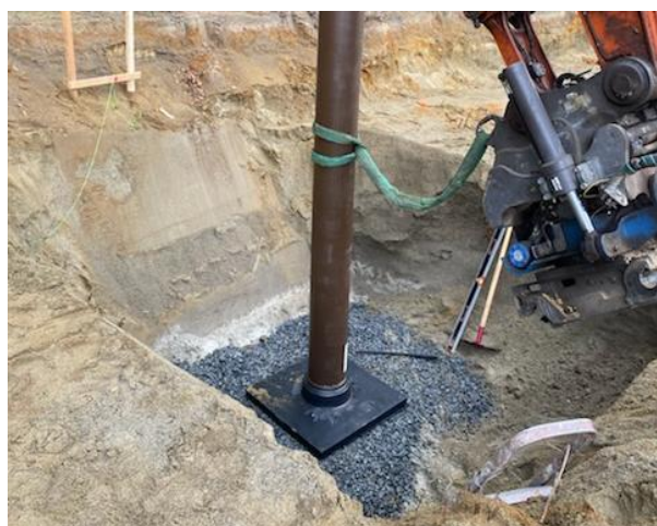
(3) punktgrävning per stolpe
