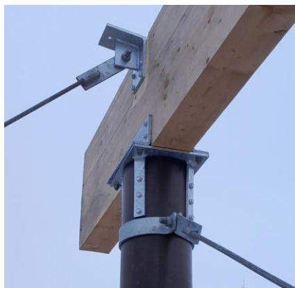
3D-skiss av stolpar med monterat limträ
