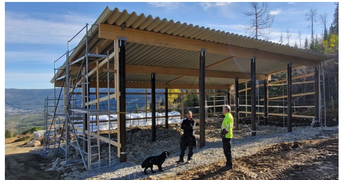
Pulpettak, 3 stolprader, snözon 6,5 kN/m 2 , redskapslager, Geilo, Norge
