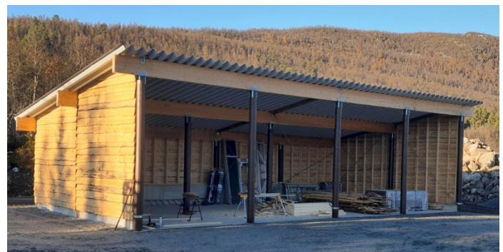
Pulpettak, 3 stolprader, snözon 6,5 kN/m 2 , redskapslager, Skurdalen, Norge
