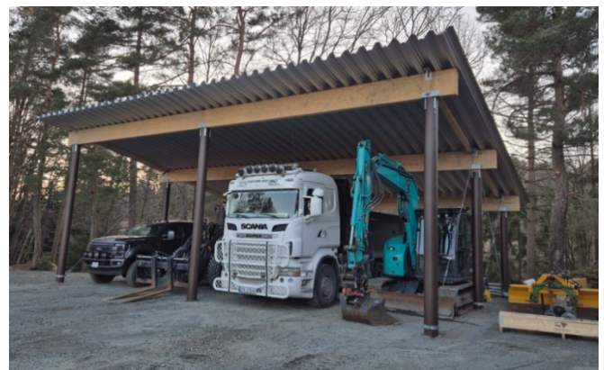
Norge Pulpettak, 3 stolprader, snözon 4,5 kN/m 2 , Lillesand, Norge
