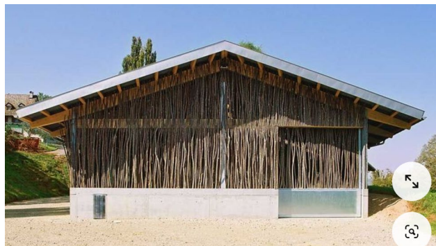
Exempelbyggnad (ej WOPAS) med slator som fasad
