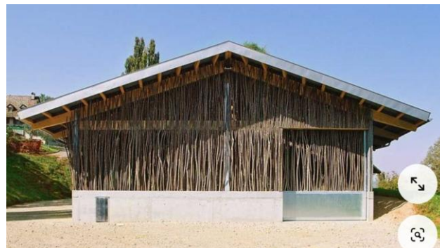
Exempelbyggnad (ej WOPAS) med slanor som fasad
