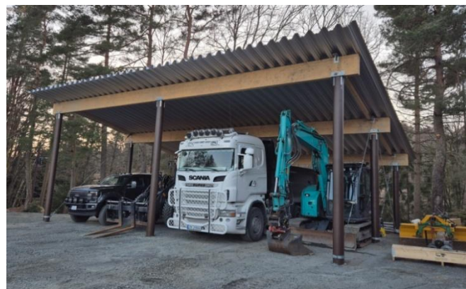
Norge Pulpettak, 3 stolprader, snözon 4,5 kN/m 2 , Lillesand, Norge
