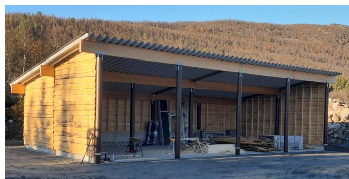
Pulpettak, 3 stolprader, snözon 6,5 kN/m 2 , redskapslager, Skurdalen, Norge
