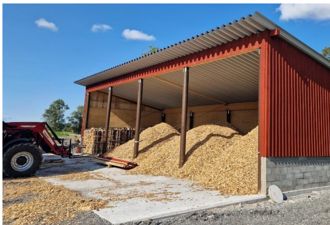
Pulpettak, 2 stolprader, flislager, Kinnekulle, Sverige
