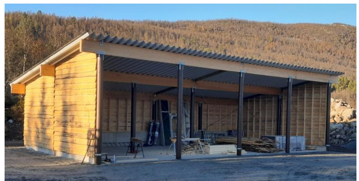
Pulttak, 3 stolperader, snøsone 6,5 kN/m 2 , flis- og redskapslager, Skurdalen, Norge
