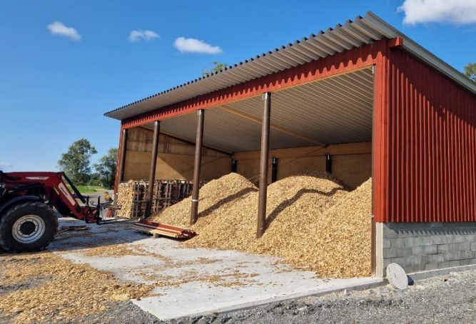
Pulttak, 2 stolperader, flislager, Kinnekulle, Sverige
