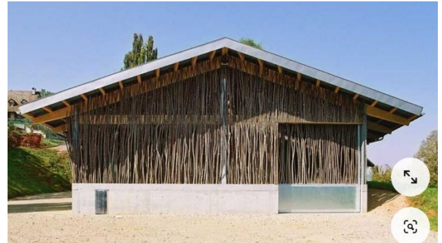
Eksempelbygg (ikke WOPAS) med slanor som fasade
