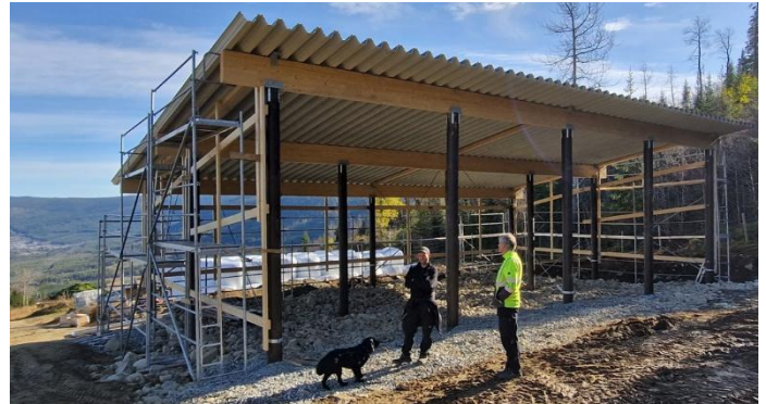
Pulttak, 3 stolperader, snøsone 6,5 kN/m 2 , redskapslager, Geilo, Norge
