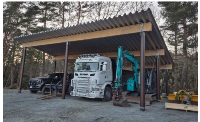
Pulttak, 3 stolperader, snøsone 4,5 kN/m 2 , Lillesand, Norge
