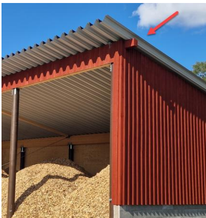
Exempel på utförande vid limträbalkens ände.
