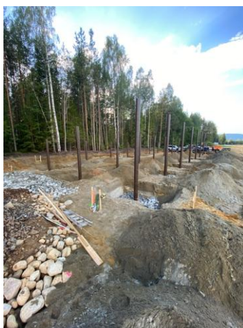
2 Dike per stolprad (vänster). 3 Punktgrävning per stolpe (mitten och höger).
