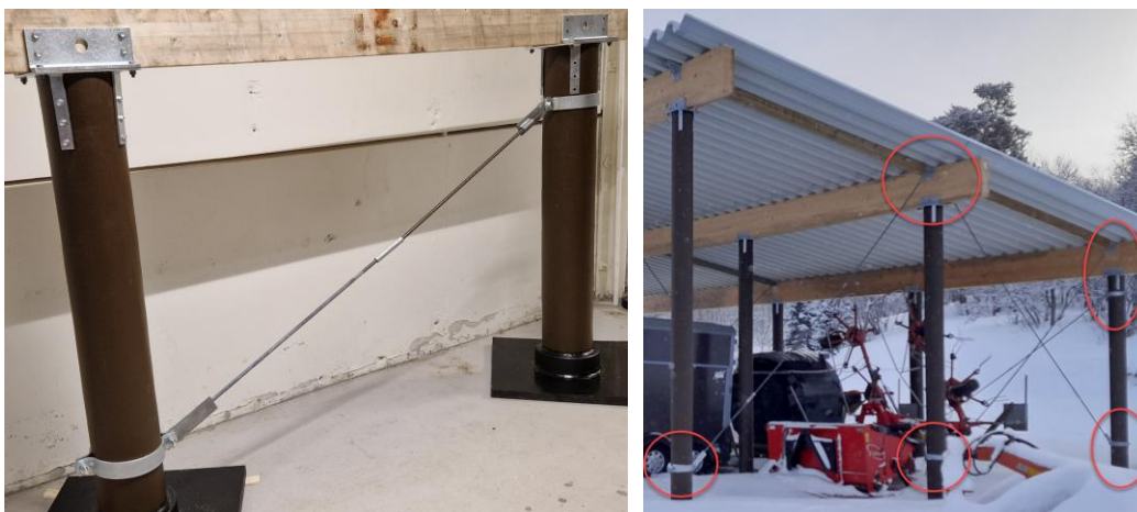
Dragstag i långsidans riktning (vänster) och tvärgående riktning (höger).
